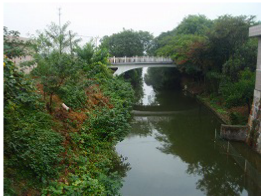
污水が排出されている川
