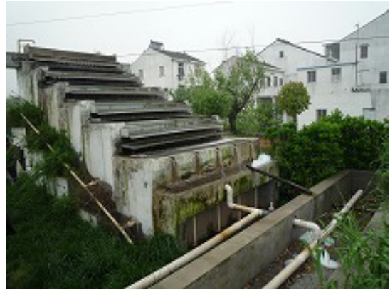
村内の汚水処理用酸化槽 (リン・窒素を処理しきれない)
