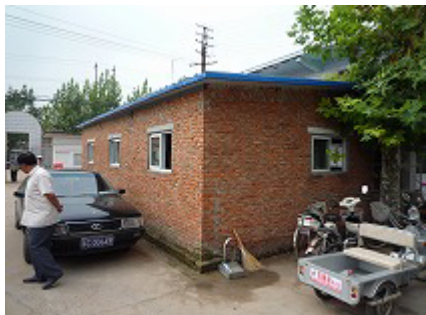
代替使用している病棟 1 (総合棟建設地確保のため、取り壊し予定)
