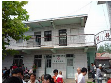
代替使用している病棟 2 (総合棟建設地確保のため、取り壊し予定)
