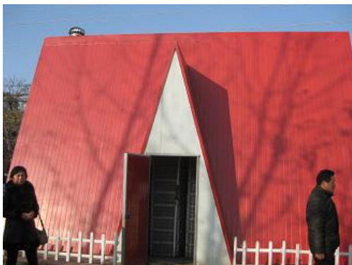
汚水処理施設
