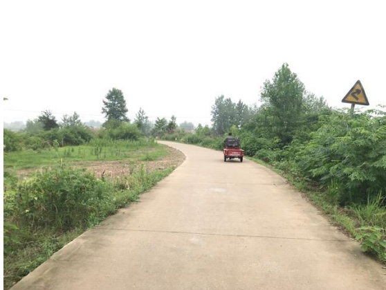
舗装した道路
