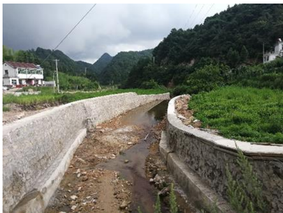
修復した護岸
