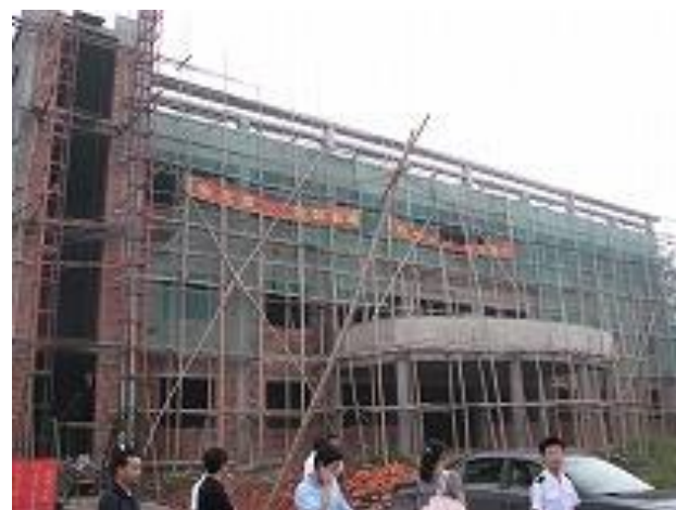
建設中の総合棟
