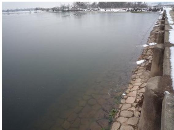
余水路（貯水池側：底面に土砂が堆積）
