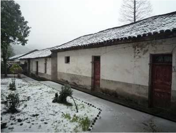
预定拆除的附属楼2栋（综合楼建设预定地）
