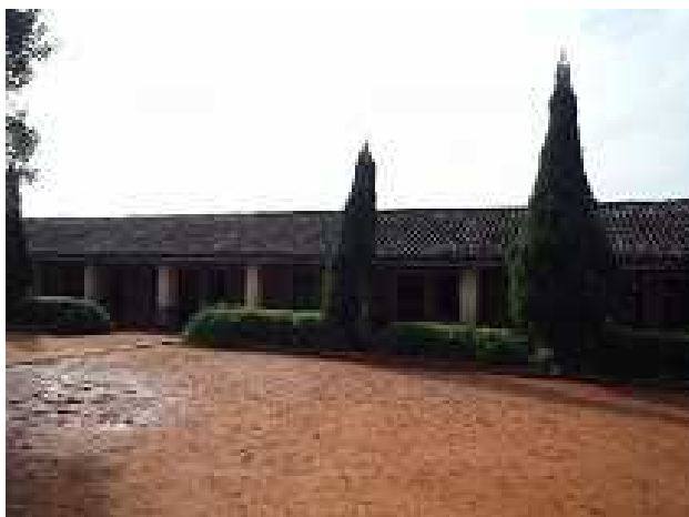
预定拆除的教学楼（综合楼预建地）
