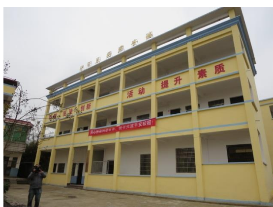
完成した総合棟の全景
