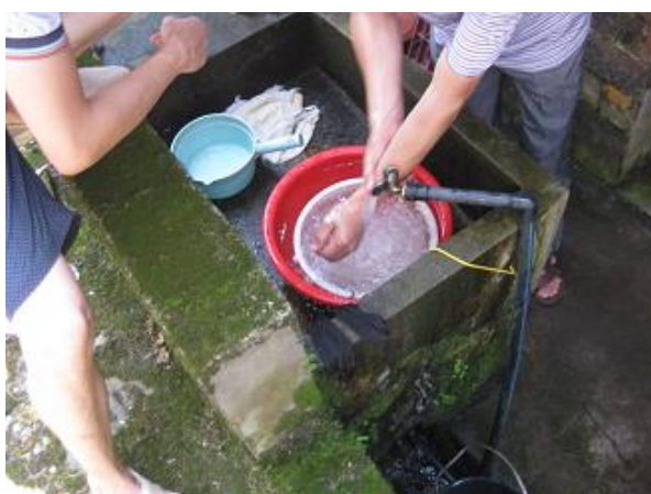
民家の配水管
