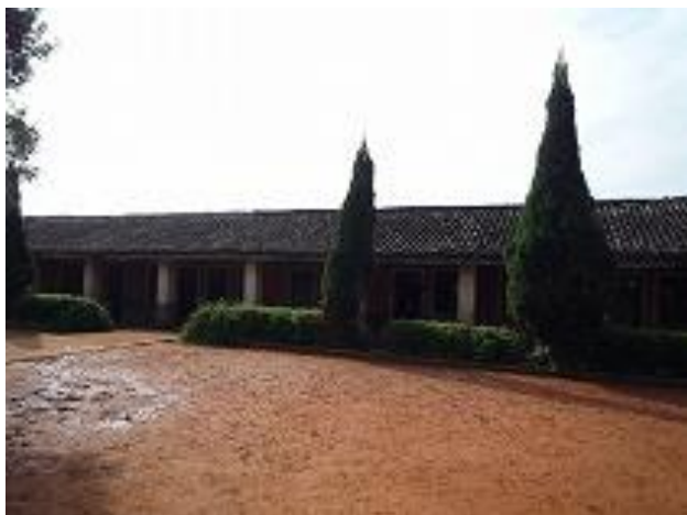
支援前の教学棟(総合棟予定地)
