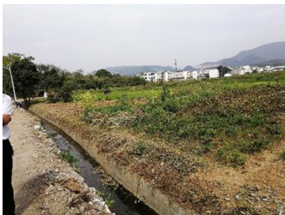
コンクリートで舗装された水路 (2019 年 9 月 25 日撮影)
