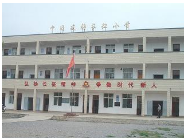
支援後の総合棟
