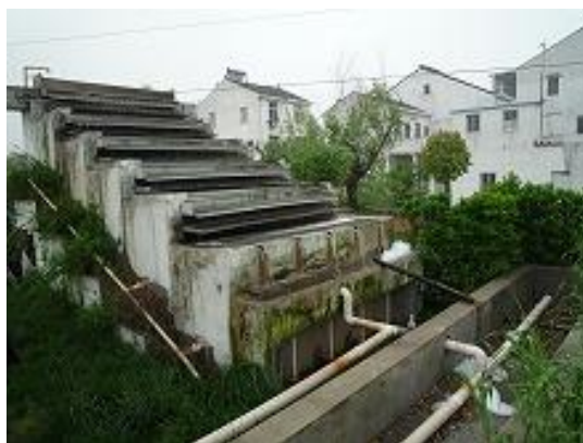
村内の汚水処理用酸化槽 (リン・窒素を処理しきれない)
