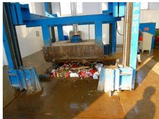
他村に設置されている同型の圧縮機
