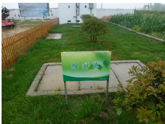
汚水処理施設設置後(地下に設置)
