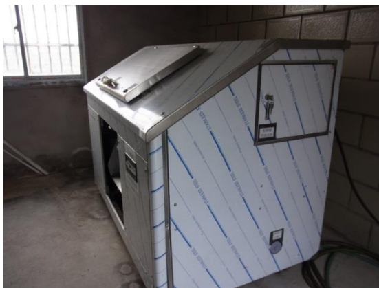
「汚水処理支援等による農民の生活環境改善事業」(平成22年度日本NGO民間連携無償資金協力)で設置したコンポスター(有機廃棄物を有機肥料へ転換する装置)
