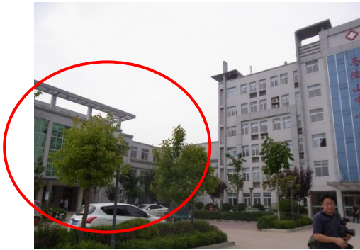
馬陵山中心衛生院の全景
