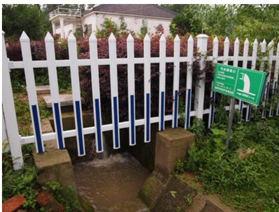
処理された汚水の排水口 (2018年7月6日撮影)
