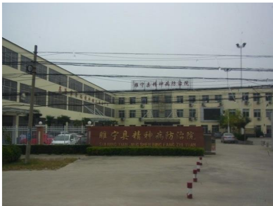
睢宁县高作中心衛生院の全景
