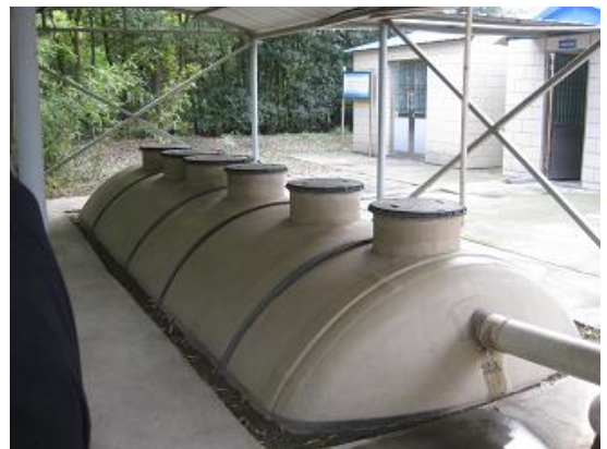
「江蘇省無錫市恵山区鉄路橋村高度処理型合併浄化槽設置計画」(平成21年度草の根無償資金協力)で設置した高度処理型合併浄化槽
