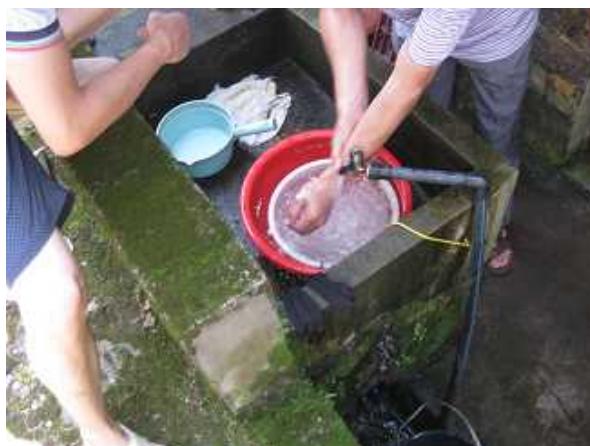
民家の配水管
