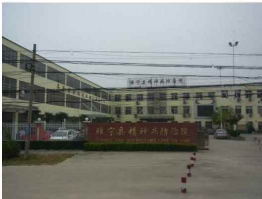
睢寧縣高作中心衛生院の全景
