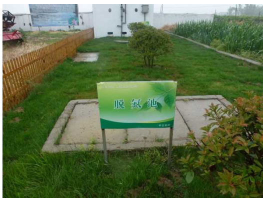
汚水処理施設設置後（地下に設置）
