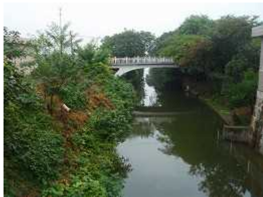
汚水が排出されている川
