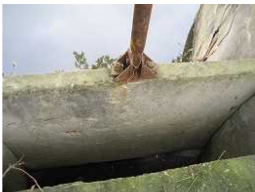
老朽化した調節水門
