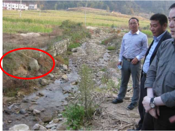
水災害で一部が崩壊したダム（護岸）
