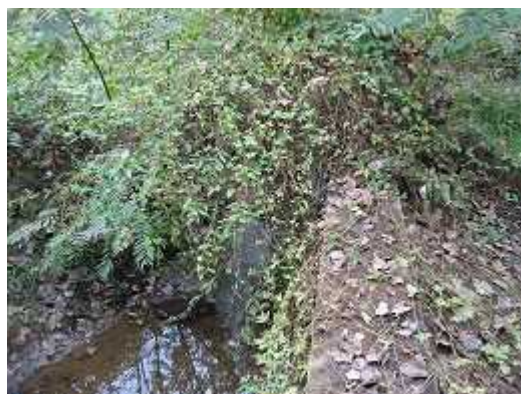
洪水で破壊された土手
