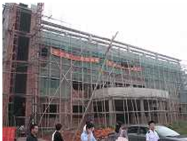
建設中の総合棟
