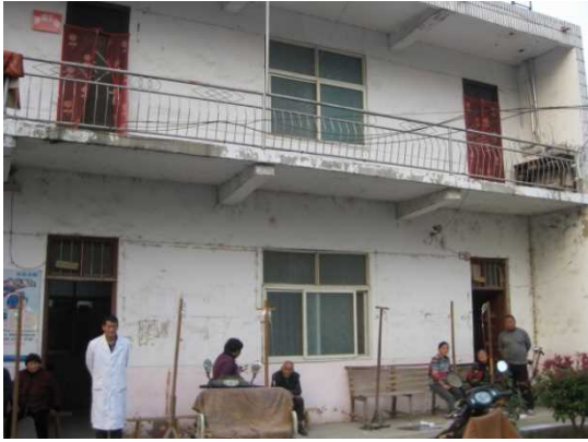
老朽化した衛生室
