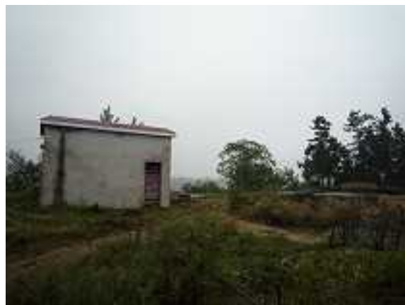
1996 年に設置した井戸と浄化槽
