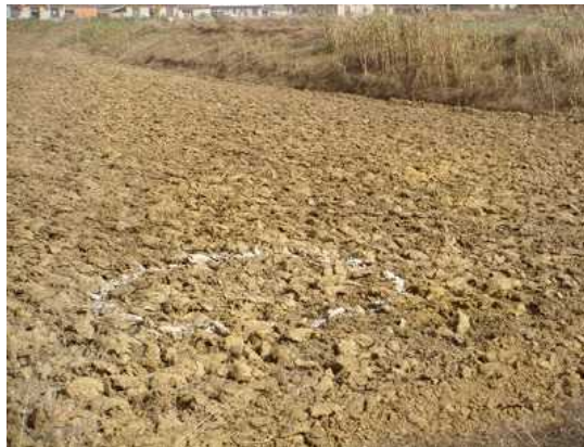
集水井の建設予定地
