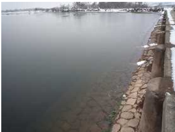
余水路（貯水池側：底面に土砂が堆積）
