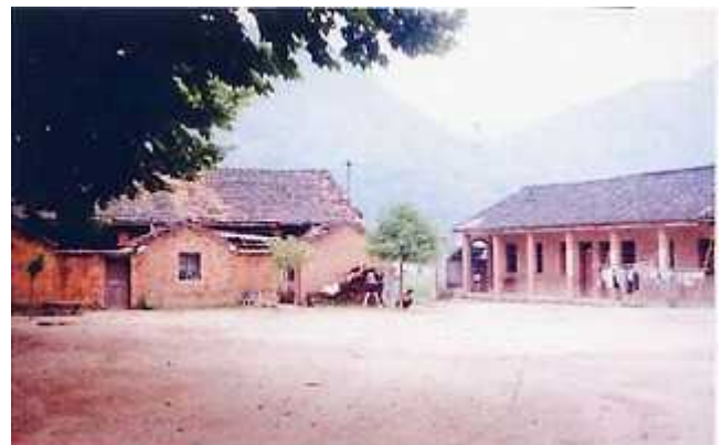
两幢房屋建于七十年代初, 经泾县房管处鉴定为C级危房, 应停止使用
