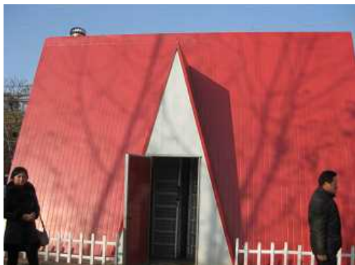
汚水処理施設
