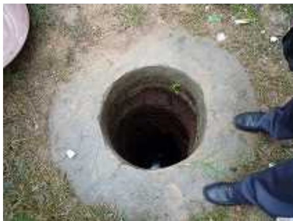
住宅地に掘られた井戸
