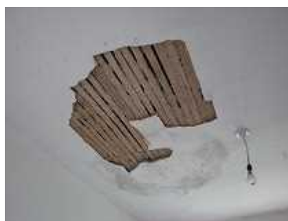
支援前の居住棟内部の様子
