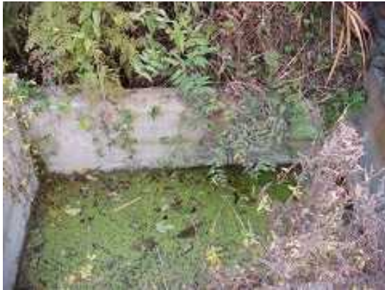
現在使用中の貯水池（1）
