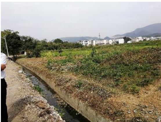
铺设水泥的水路
