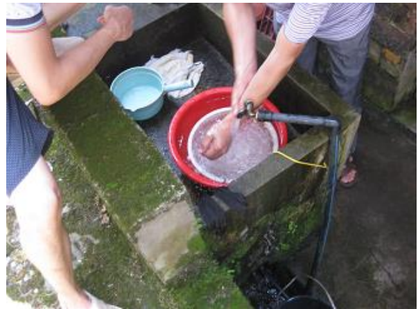
民家的供水管
