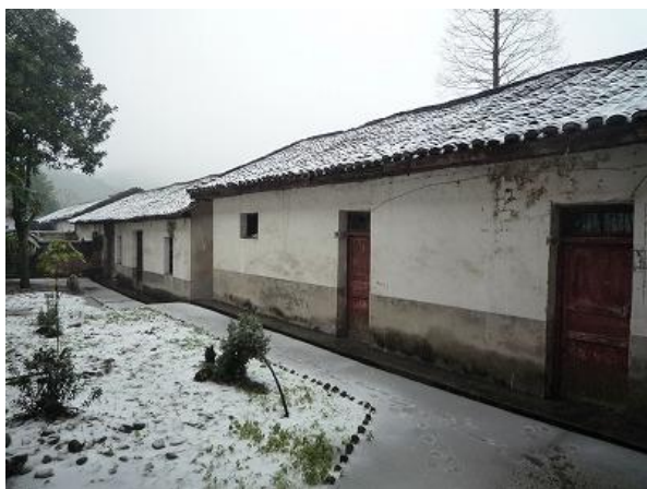
预定拆除的附属楼2栋（综合楼建设预定地） (援助后)
