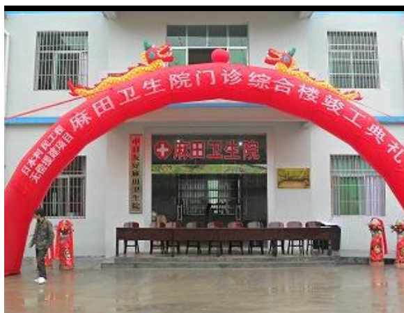
此次支援的综合楼外观
