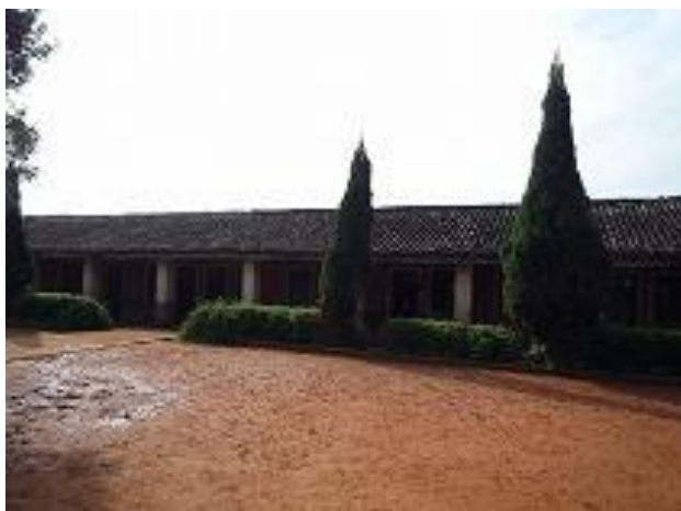
预定拆除的教学楼（综合楼预建地）
