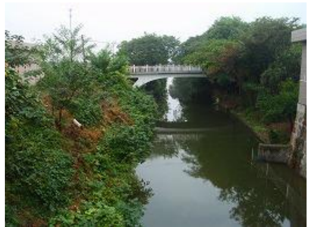
污水排入的河流
